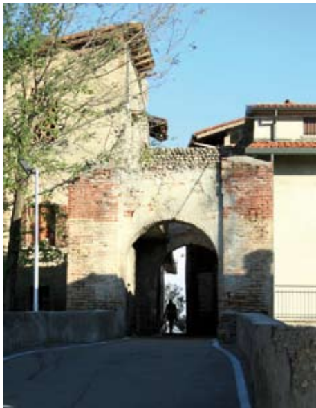
112. Civitate al Piano, l'ingresso al castello
