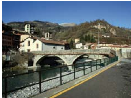
7. La ciclovia a Ponte Nossa
