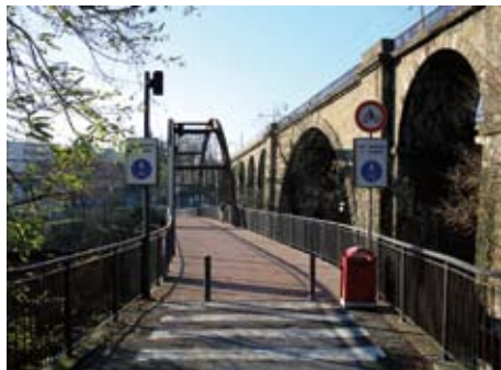
60. La passerella sul Brembo a Ponte San Pietro
