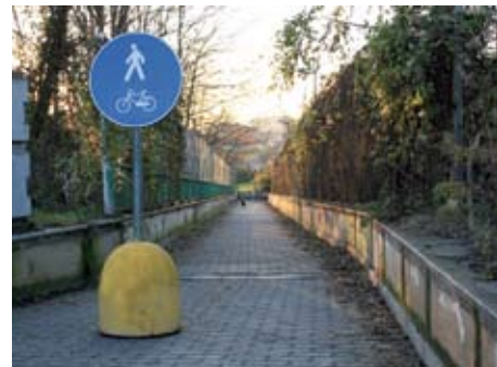
59. Il sottopasso della ferrovia a Seriate
