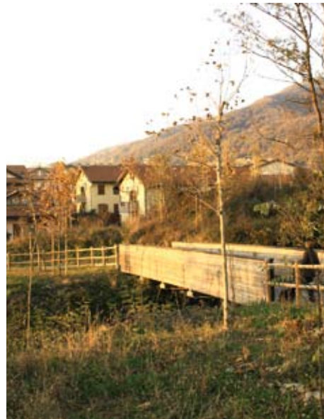
64. La passerella ciclopedonale presso le scuole di Carvico
