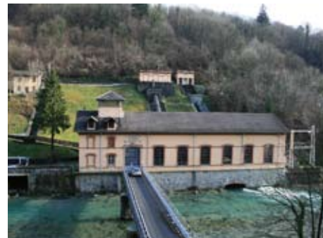
44. San Giovanni Bianco, centrale elettrica
